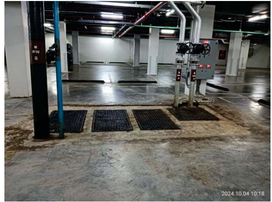
รูปที่ 3-30 ระบบถังดักไขมัน
